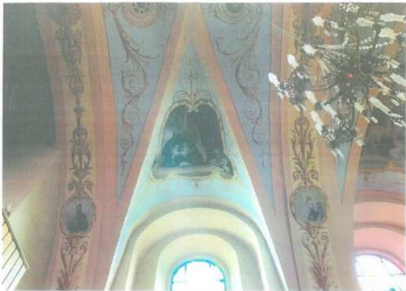
Fot. 12 Wyszogród. Kościół p.w. św. Trójcy. Fragment sklepienia
