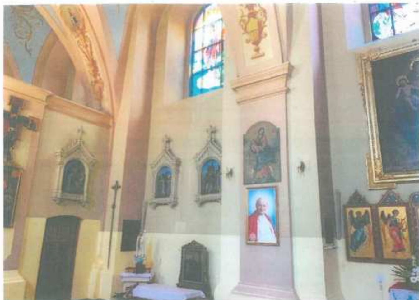
Fot. 4 Wyszogród. Kościół p.w. św. Trójcy. Fragmęnt ściany południowej
