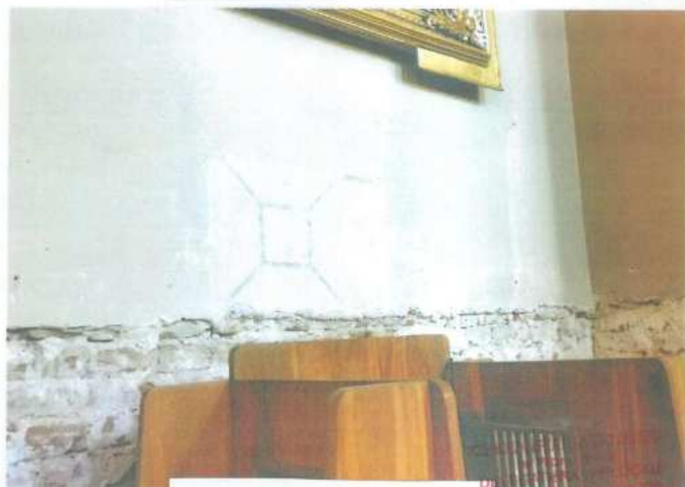
Fot. 11 Wyszogród. Kościół p.w. św. Trójcy. Odkrywka na ścianie południowej
